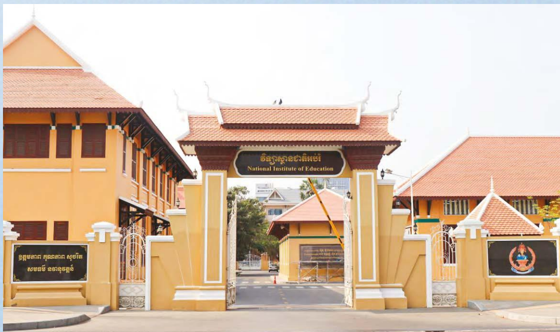
Porte d'entrée de l'INE, rénovée en 2023
